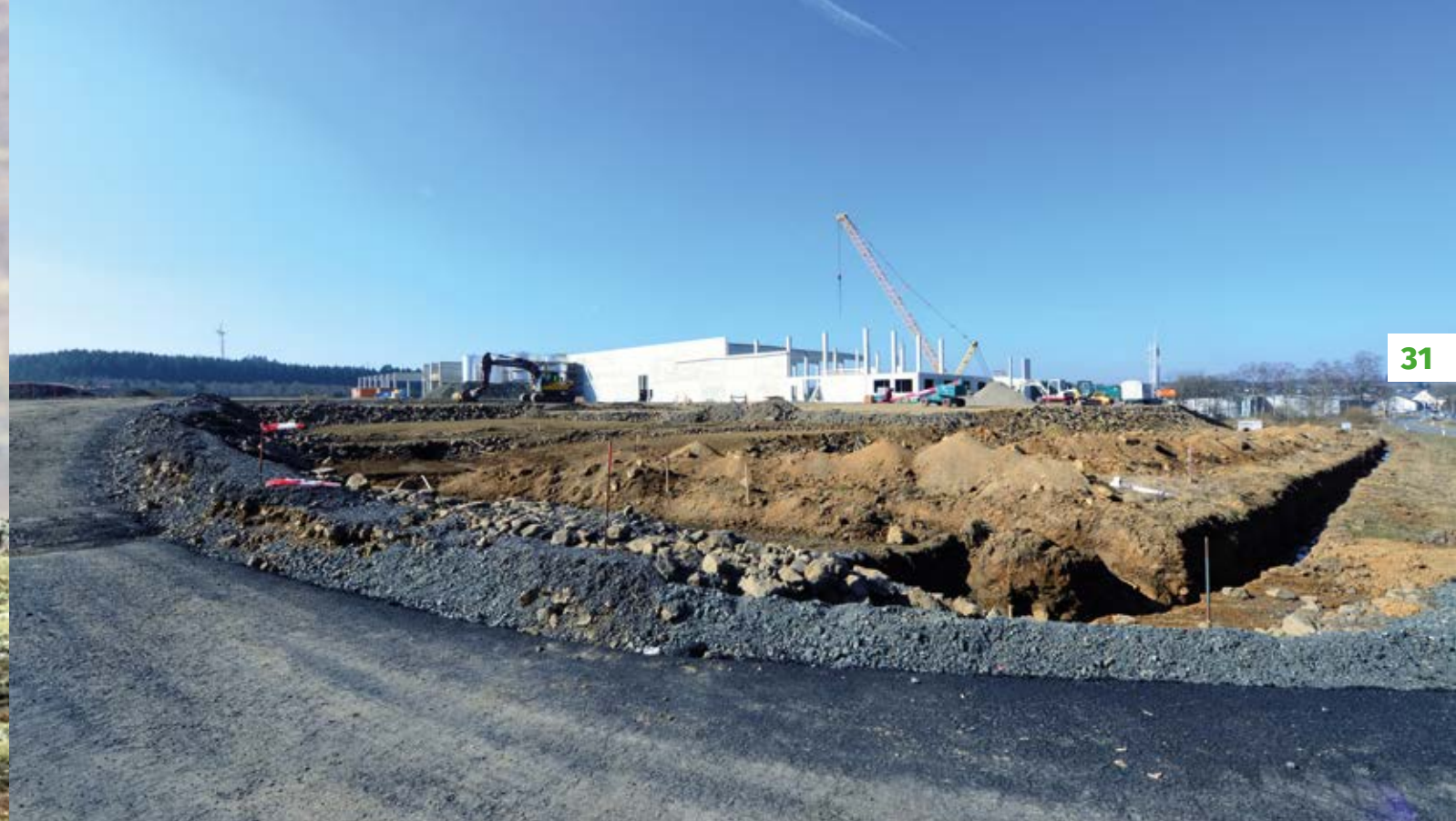
Fortschreitende Flächenversiegelung für Bau- und Gewerbegebiete
